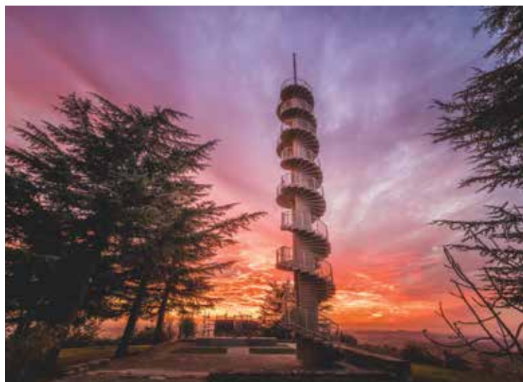
Osmatračnica Gonjače, odakle se pruža pogled od mora do Alpa
